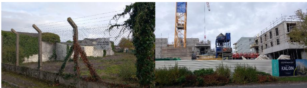
Figure n° 11 : Parc à huiles et quartier de Kerfréhour
