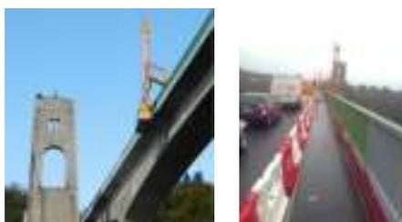
Sécurisation des culées et vérinage et changement d'appareils d'appui
